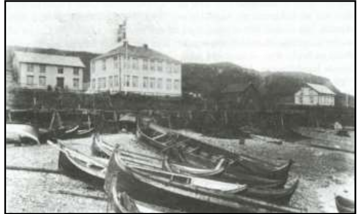
Her er et bilde fra Loppa ca 1900 med skolen til venstre og prestegården til høyre og handelsmannens hus i midten og med båtene i støa
